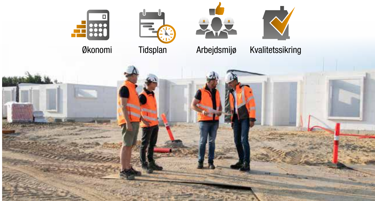
Projektledelsen træder for alvor i karakter efter projekteringsforløbet, nu starter arbejdet og skurbyen etableres på byggepladsen.
